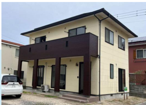
<改修前の外観>
