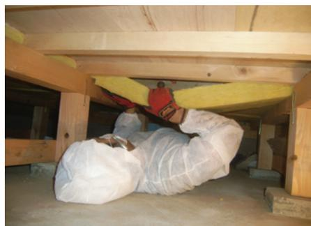
床下から根太間に断熱材を設置する
