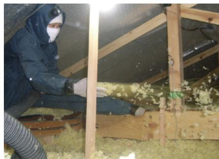
小屋裏にバラ状断熱材を吹き込む
