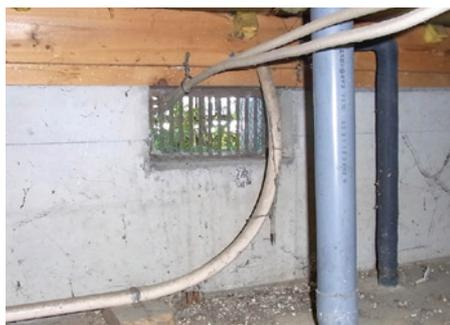
床下換気孔は外部への配管・配線ルートに使用されている場合もあり、換気量が足りないことがある。
