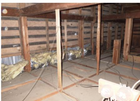
小屋裏調査：天井は無断熱、外壁には断熱材が設置されている。雨漏り跡や軸組の状態も確認する
