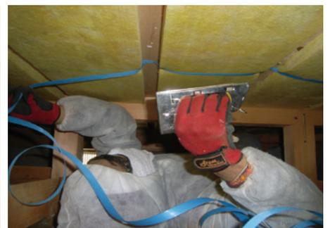
落下防止材を根太下に打付ける
