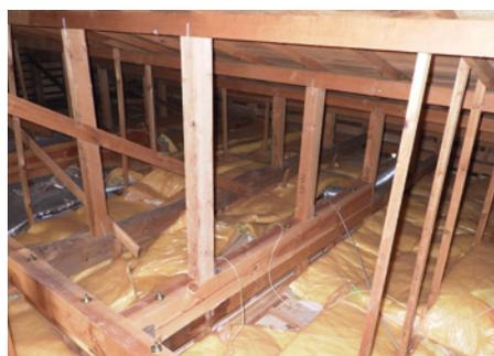
小屋裏調査：断熱材は、設置されているが、再利用する場合は、欠損部への充填や敷直しが必要など、設置状況を確認する
