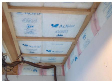
野縁を組み断熱材を充填した現場
