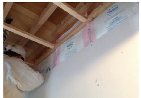
間仕切壁上端に気流止めを設置する
