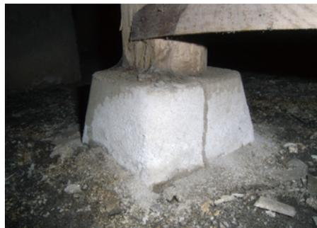
床下調査：束石に確認された蟻道。劣化や蟻害、雨漏り等も同時に確認する
