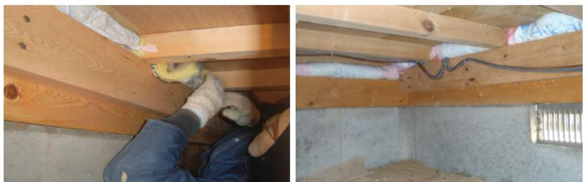
繊維系断熱材を気流止めに使用する場合は、防湿層を外側にU字に折り畳んで、図のように挿入すること。
