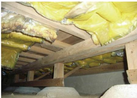
床下調査：床に設置された断熱材。部分的な欠損や外れ等、設置状況を確認する
