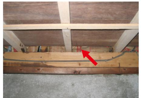
床下調査：矢印箇所から確認された外壁の断熱材。外壁の断熱材は床下からも確認できる
