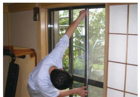
開口部調査：開口部回りは詳細に寸法を確認すると共に、窓台の腐朽劣化等を確認する
