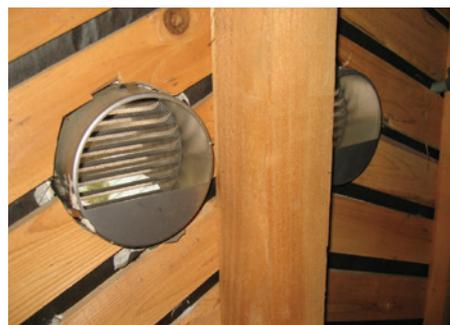
小屋裏の換気量を増やすために後付けされた2箇所換気孔
